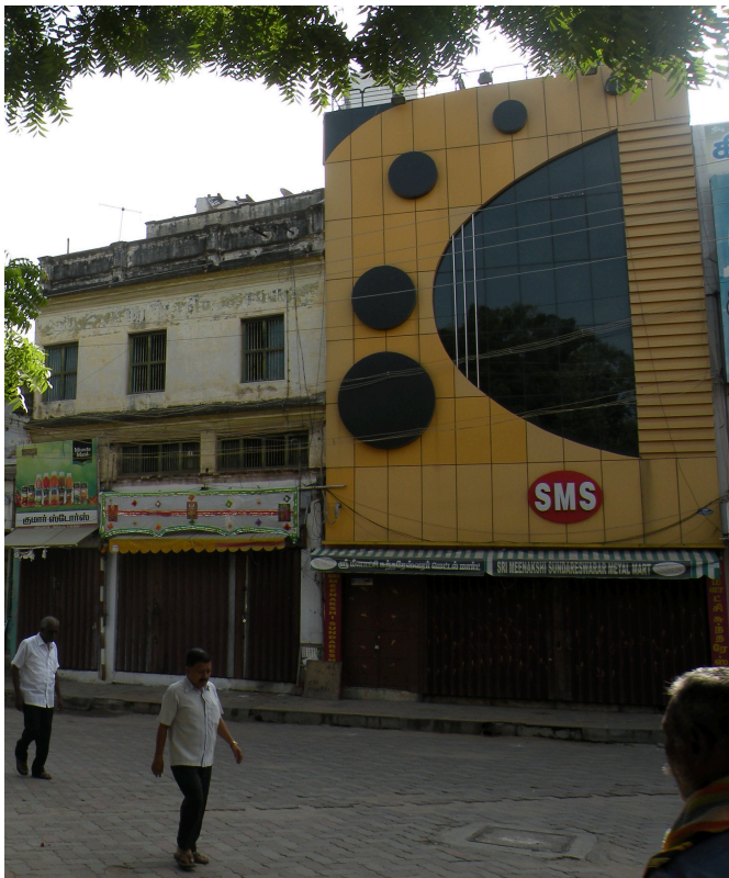
Fig. 18. Nouveau bâtiment de la rue de Cittirai (photo A. Viguiier, 2017).
